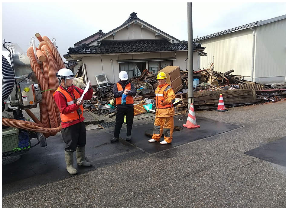
写真 3.6-4 能登半島地震での復旧活動
