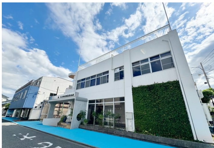
写真 3.4-1 土志田建設株式会社 横浜市緑区
