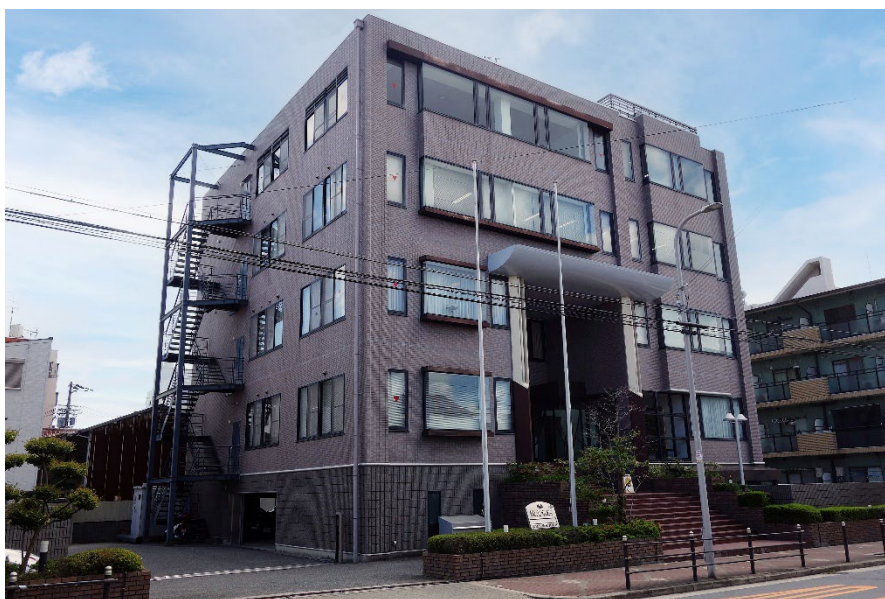
写真 3.5-1 株式会社久本組本社（大阪市住吉区）
