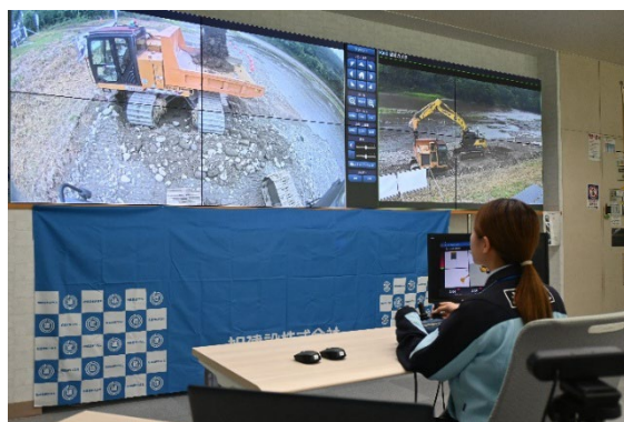
写真 3.7-2 建設ディレクターによる無人化施工
